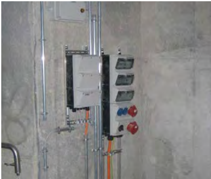
ÖBB (Österreichische Bundesbahn), Lainzer Tunnel, Wien, Österreich
